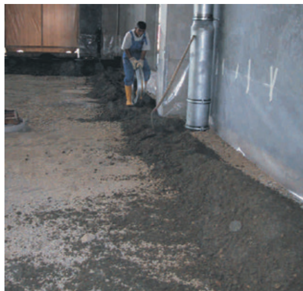
Bild 2: Verlegung des Erders auf einem Bett aus Walzbeton
