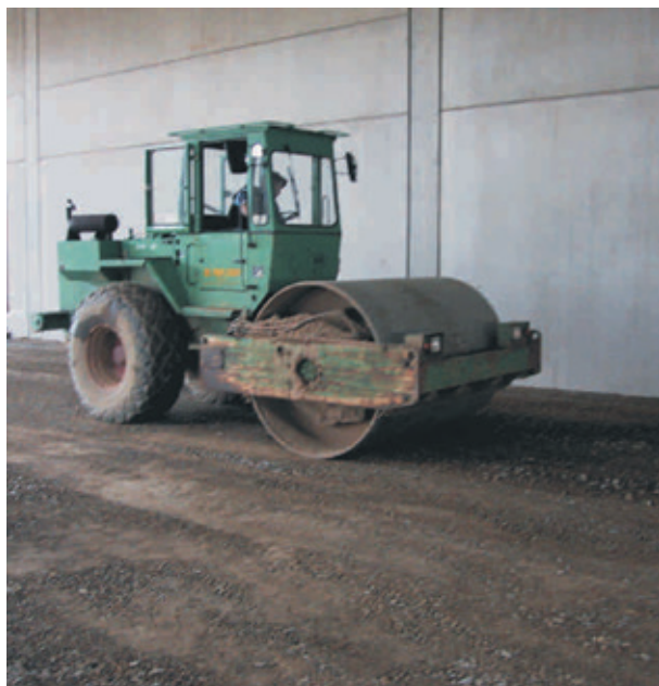
Bild 1: Vibrationswalze zum Verdichten von Walzbeton
