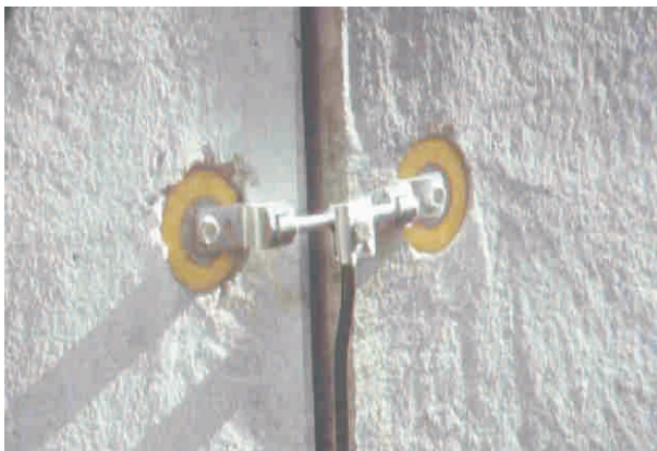
Bild 2: Verbindung der Bewehrung zweier Fertigteile und Abzweig zum Fundamenterder
