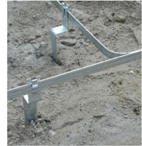
Kann eine allseitige Umhüllung mit Beton von mindestens 5 cm nicht sichergestellt werden, z.B. auf Grund der Einbringtechnik des Betons, ist ein Ringerder zu errichten.
