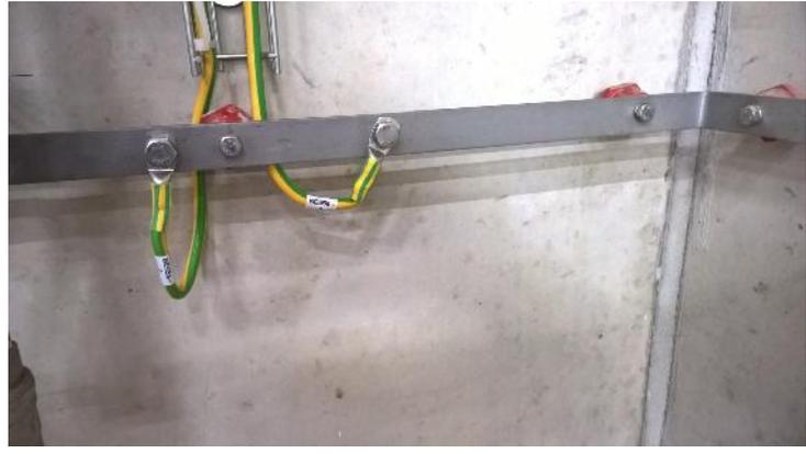
**Bild 15:** Anschlüsse metallener Bauteile an das V4A Flachband an der Wandebene mit dem Vorteil der kurzen, flexiblen Leitungswege
