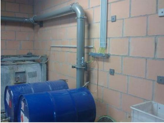
Bilder 22 – 58: Ausführung unterschiedlicher Erdungsanschlüsse in Ex-Ausführung für leitfähige Konstruktionen
