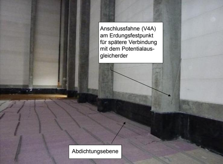
Anschlussfahne (V4A) am Erdungsfestpunkt für spätere Verbindung mit dem Potentialausgleicherder
