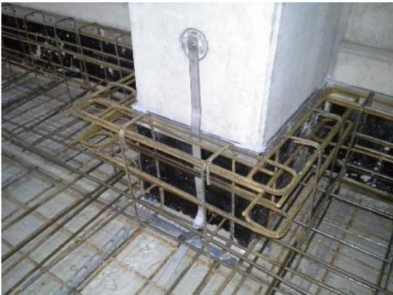
Bild 9: Anschluss Erdungsfestpunkt an den Potentialausgleicherder oberhalb der Abdichtungsebene. Andere Art der Abdichtung bestehend aus einer Abklebung (schwarz) und einem vorgesetzten Betonstreifen
