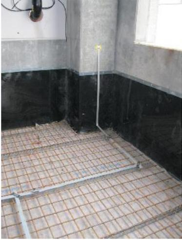
Bild 6 – 8: Anschluss Erdungsfestpunkte an den Potentialausgleicherder oberhalb der Abdichtungsebene (= Anbindung an V4A-Ringerder)
