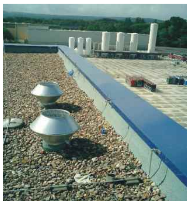
Bild 14: Fangeinrichtungen und Fangspitzen
