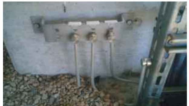
Bild 23: Anschluss einer Kabelpritsche (Ausführung aller Materialien aus nichtrostendem Stahl)
