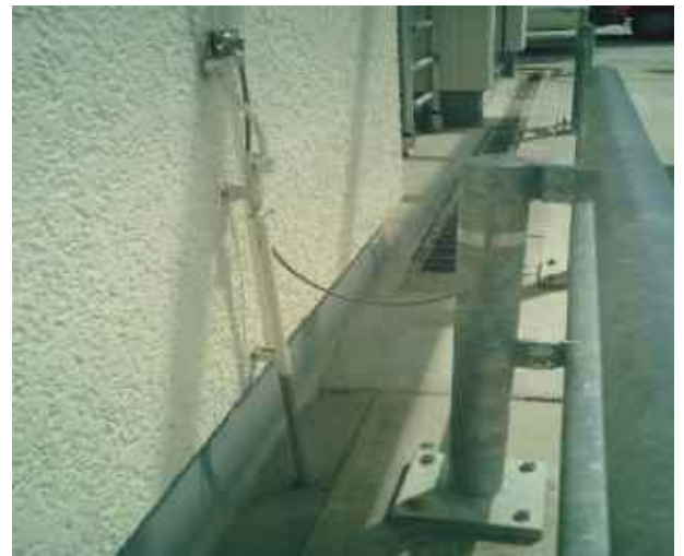
Bild 9: Trennstelle mit Nummerierung und flexiblem Anschluss an demontierbarem Rammschutzgeländer
