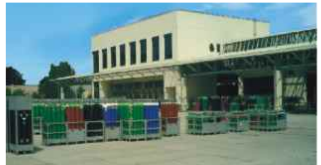
Bild 2: Abfüllhalle mit Lagerfläche
