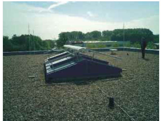
Bild 13: Getrennter Schutz eines Lichtbandes mit elektrischer Sonnenschutzeinrichtung
