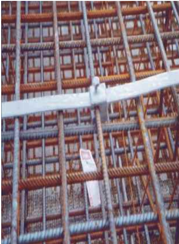
Bild 5: Anschluss an die Bewehrung
