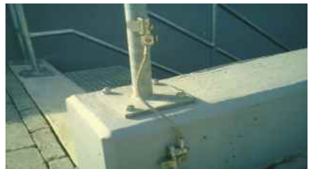
Bild 17: Potentialausgleich für Geländer
