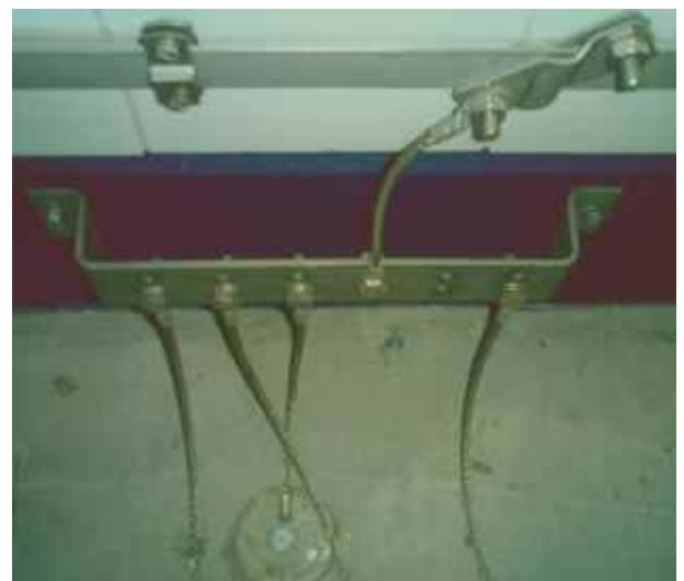
Bild 21: PA-Schiene mit Erdungsfestpunkt und Erdungssammelschiene
