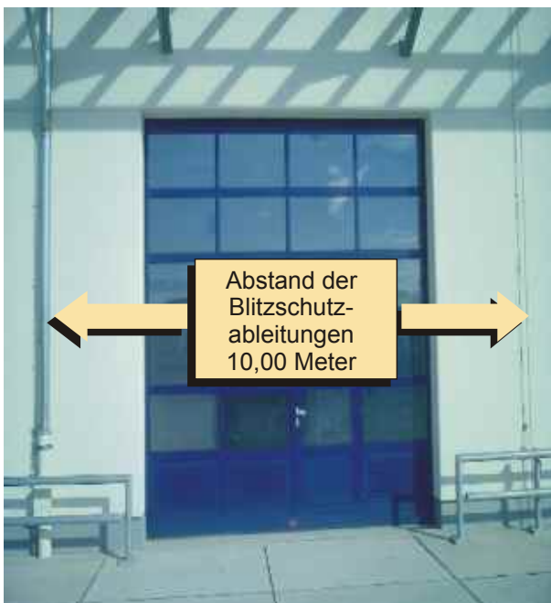
Bild 8: Lage und Abstand der Ableitungen
