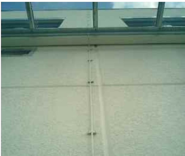
Bild 7: Ableitung nichtrostender Stahl
