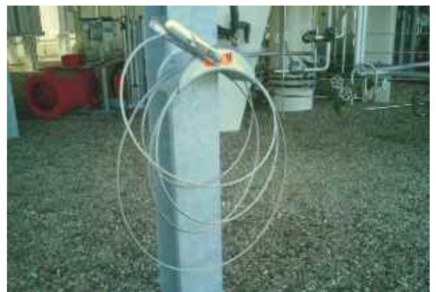
Bild 24: Erdungsvorrichtung für Tankfahrzeuge
