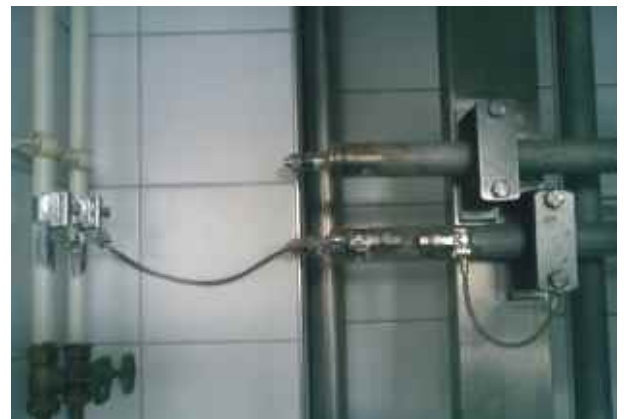
Bild 20: Anschluss einer Tür
