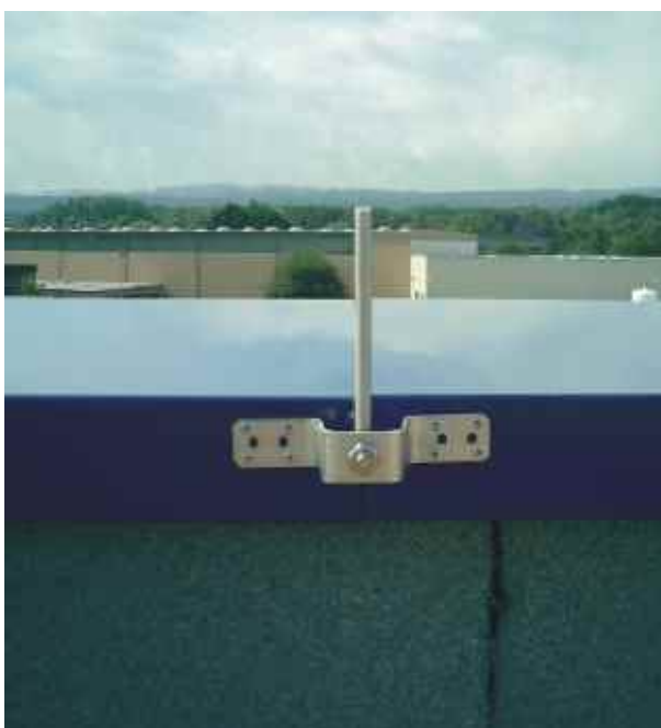
Bild 12: Fangspitze an Dachattika
