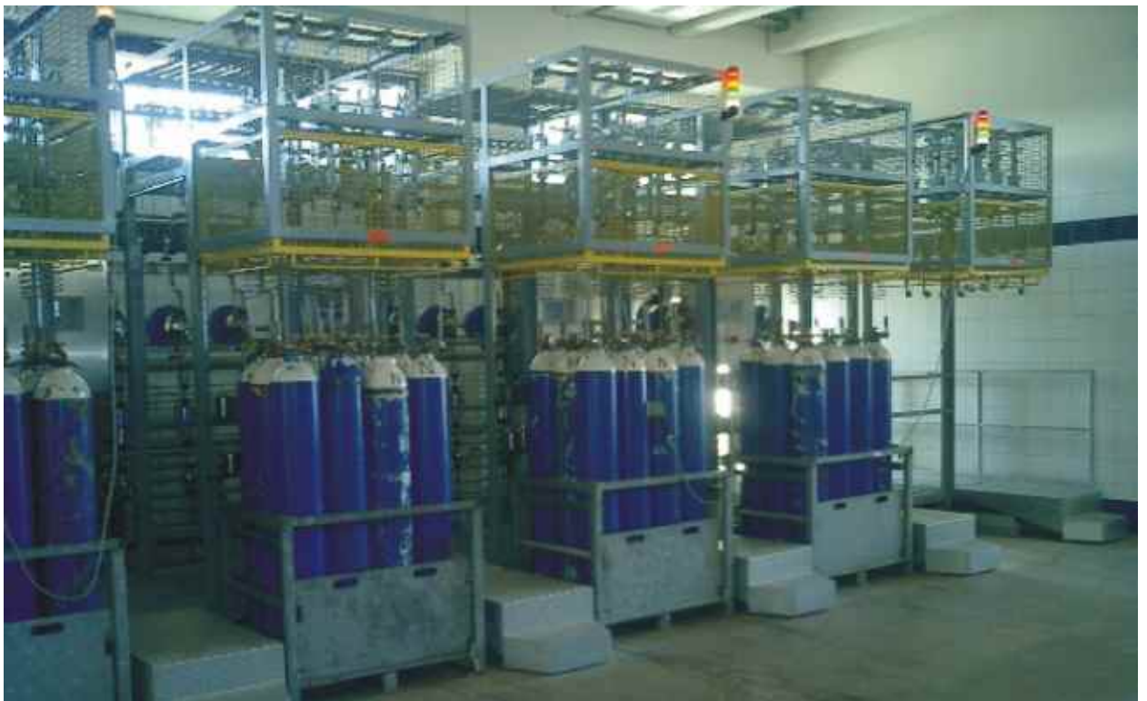
Bild 4: Innen liegender Abfüllbereich
