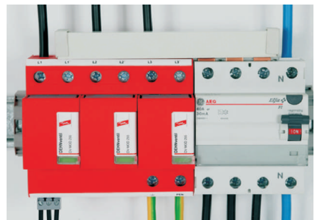
Bild 7: V-Verdrahtung mittels Kammschiene
