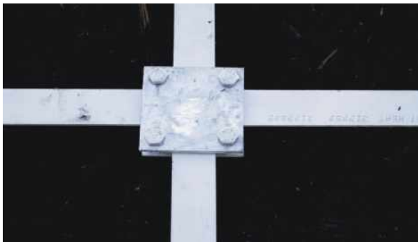
Bild 1: Kreuzverbinder nach DIN 48845
