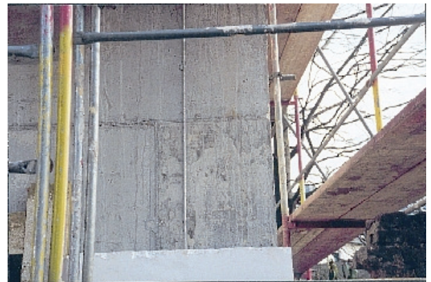
Bild 2: Beispiel für eine Ableitung hinter Dämmputz
