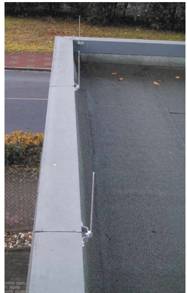
Bild 5: Schutz der Metalllattika durch Fangspitzen
