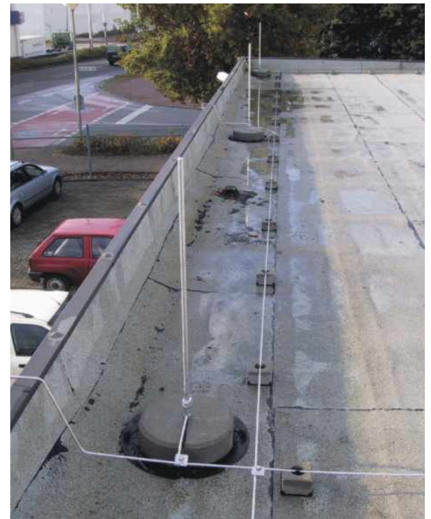
Bild 8: Schutz der Metallattika durch die Anordnung von Fangstangen
