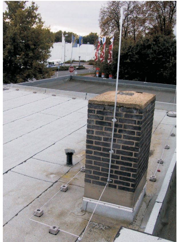
Bild 2: Fangstange am Schornstein
