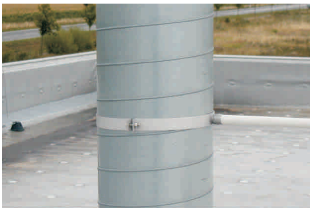
Bild 2: Befestigung des seitlichen Isolierstützers mit einer Bandschelle
