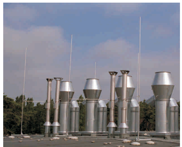
Bild 5: Fangstange mit Dreibeinkonstruktion und seitlichem Isolierstützer
