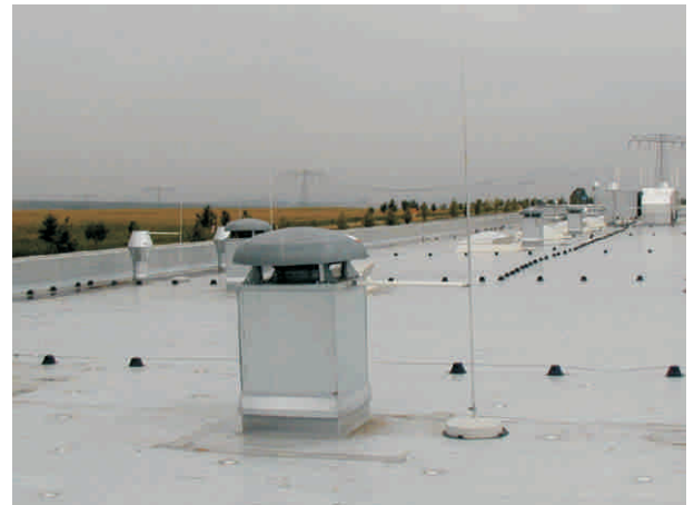
Bild 3: Fangstange mit seitlichem Isolierstützer
