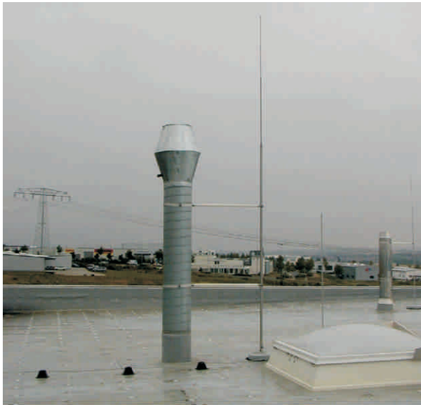
Bild 1: Fangstange mit seitlichem Isolierstützer und Betonstandfuß mit großem Durchmesser
