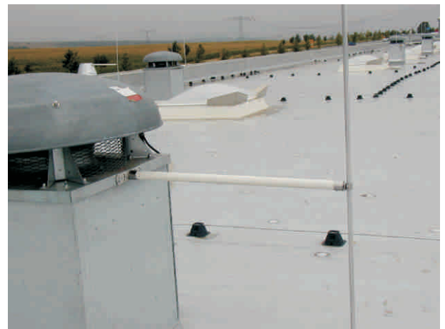
Bild 4: Befestigung des seitlichen Isolierstützers mit einem Befestigungswinkel
